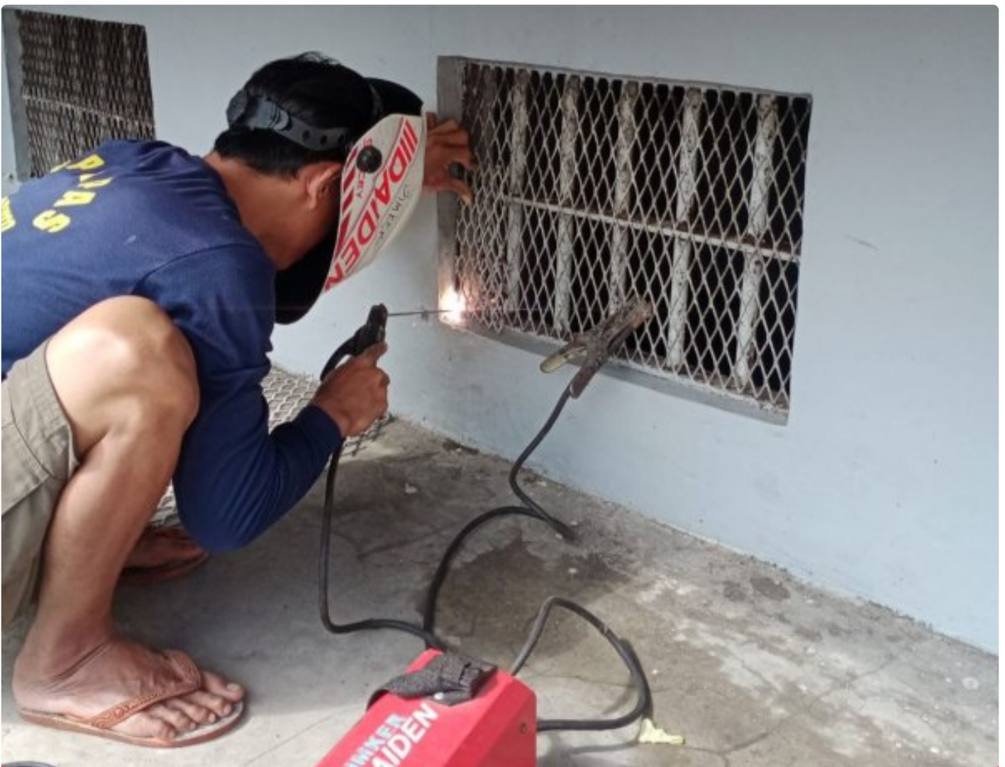
Lapas Kelas IIA Purwokerto Lakukan Rehabilitasi Bangunan
